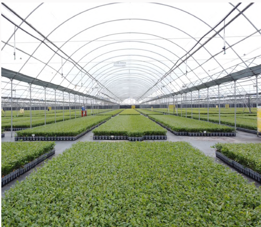
Imagen obtenida en las instalaciones de Fall Creek Perú (Cañete-Lima)
